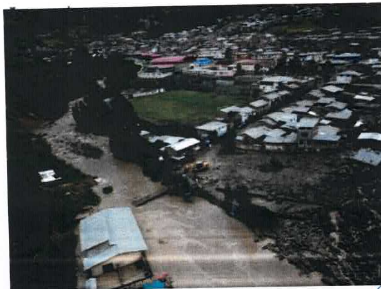
Fotografía N° 01: Relieve de la zona de estudio
