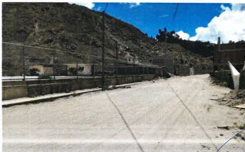
Fotografía N° 04: Vista de viviendas en zonas de alto riesgo por deslizamiento.
