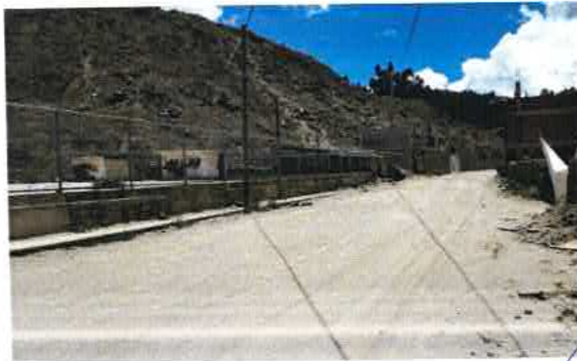
Fotografía N° 04: Vista de viviendas en zonas de alto riesgo por deslizamiento.
